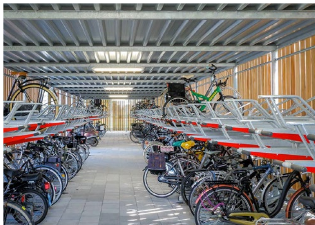
Doppelseitige Anlage in einer Velostation
